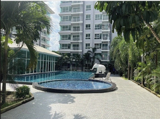
อาคารชุดเดอะ รอยัล ฮิลล์ รีสอร์ท บ่อวิน (บนโฉนด 78149) ต.บ่อวิน อ.ศรีราชา จ.ชลบุรี
