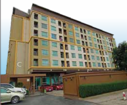
อาคารชุดพลัม คอนโด แหลมฉบัง 2 ที่ตั้ง (บนโฉนด 32084) ถ.เมืองใหม่กลาง ต.ทุ่งสุขลา อ.ศรีราชา จ.ชลบุรี
